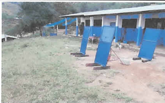
Foto 5: Sustitución de portón y mantenimiento a puertas del servicio sanitario
