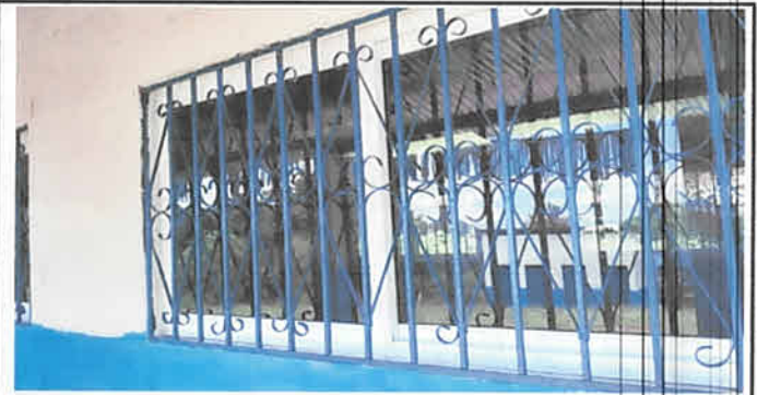
Foto 6: Sustitución de ventanas antes de madera se están instalado ventanas de vidrio y pvc
