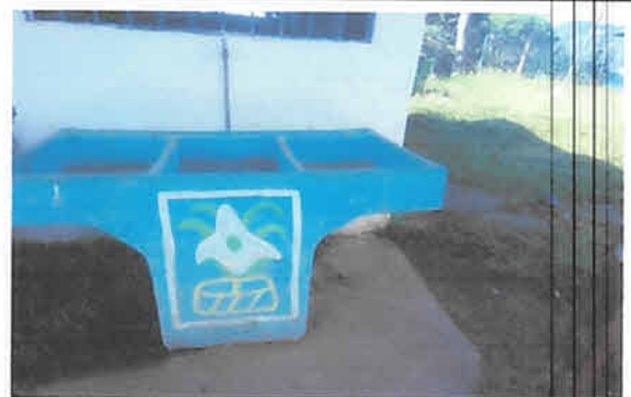
Foto 4: Sustitución de pila en el área de la cocina
