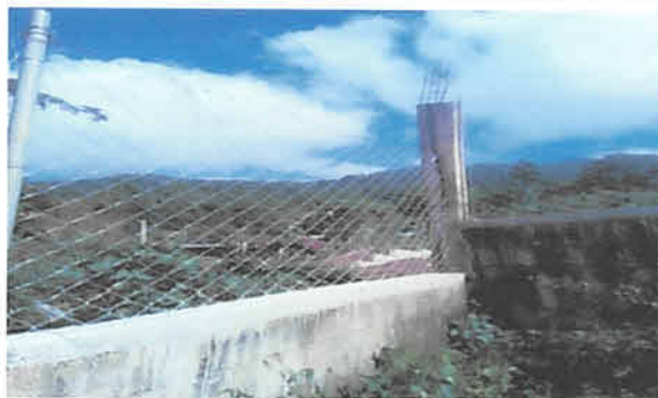
Foto 3: Reparación de muro perimetral con malla y concreto
