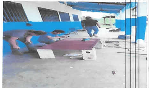
Foto 2: Reparación y pintado de puertas de todo el centro educativo. Pintadas de color azul
