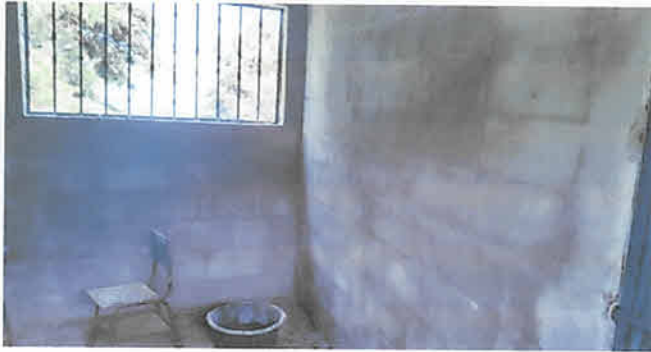
Foto1: Repellando área interna y externa de cocina. Con monocapa gris.
